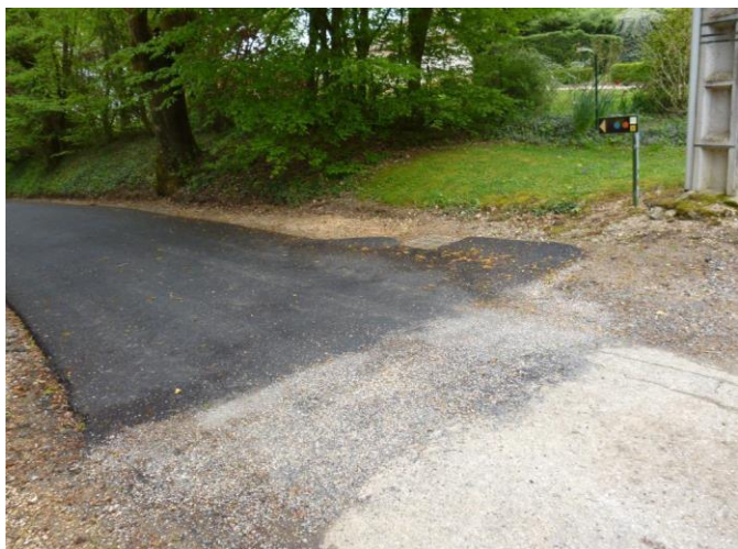
Chemin du pont des Sires
