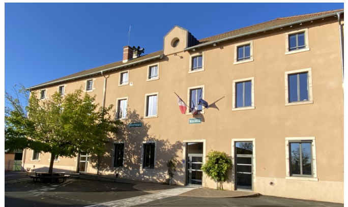
Nouvelle façade sans volets extérieurs
