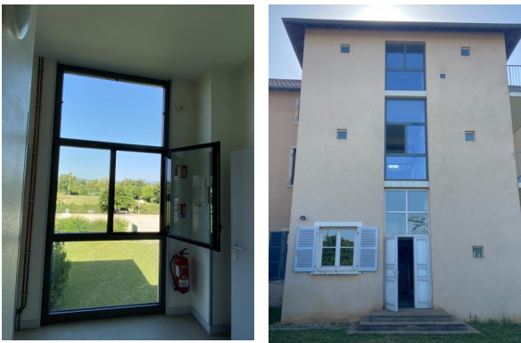
Pose des menuiseries en cours
